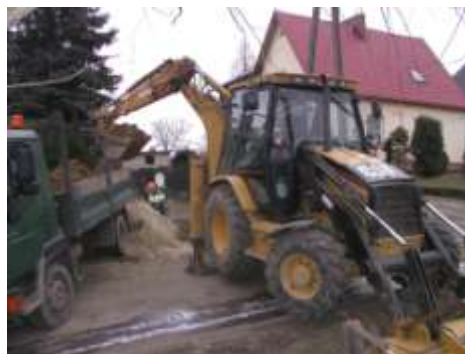
Zadanie w trakcie realizacji
